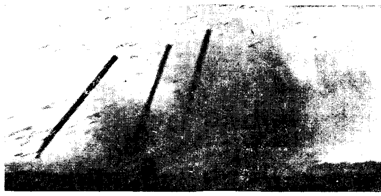
HET RESULTAAT. Achthonderd gram trotyl doen hun werk: met een dof-fen knal slaan de palen stuk en vliegen nog enkele meters de lucht in.
